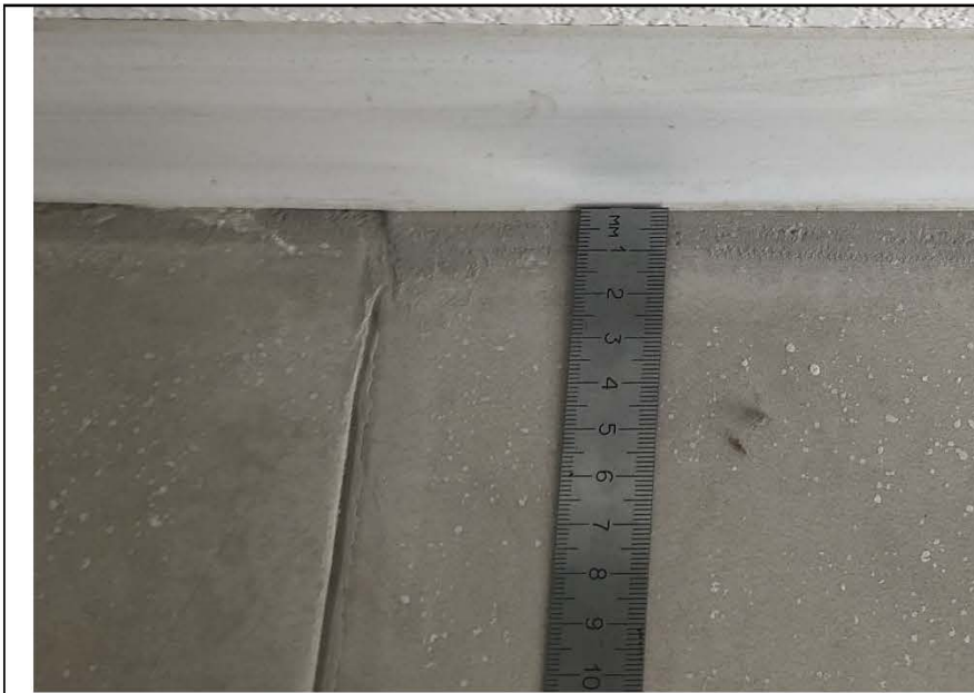
Фото №25. Измерение плиточного шва в коридоре в квартире.
