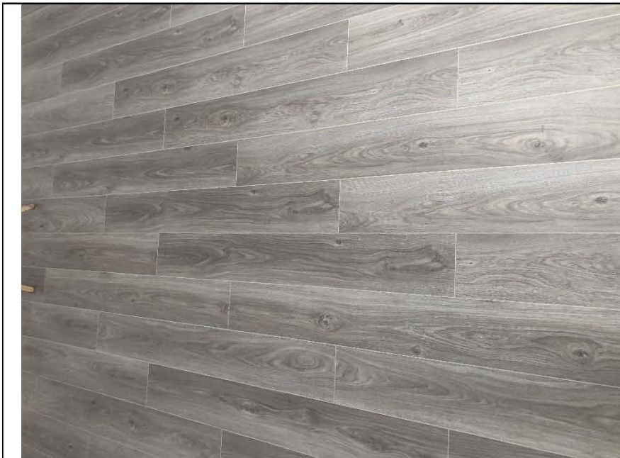
Фото №13. Общий вид напольного покрытия на комнате в квартире.
