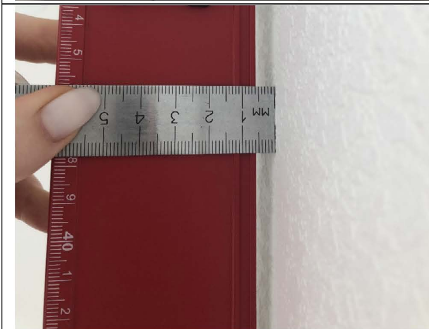
Фото №15. Измерение уровня стен кухни в квартире.
