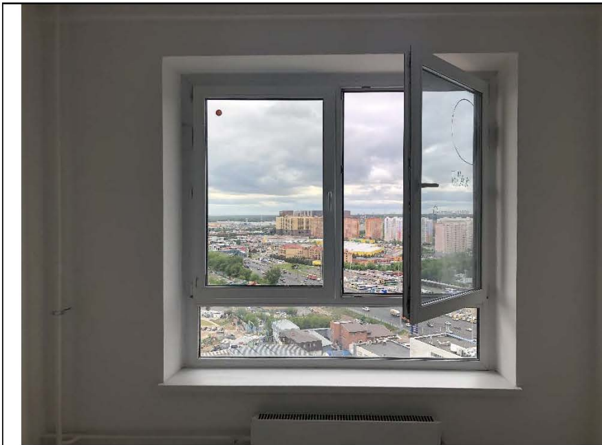
Фото №10. Общий вид оконного блока кухни в квартире.
