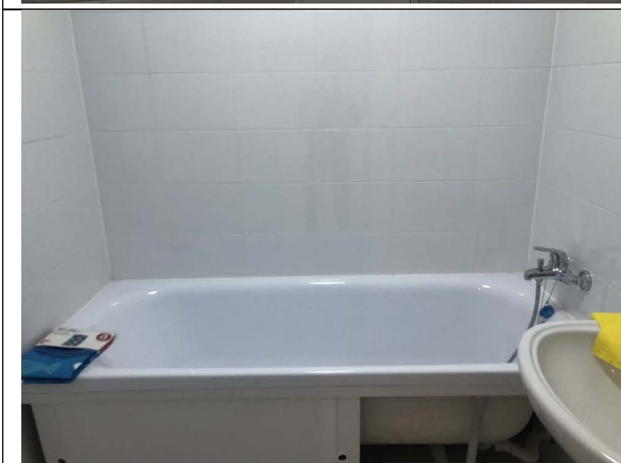
Фото №6. Общий вид ванной комнаты в квартире.
