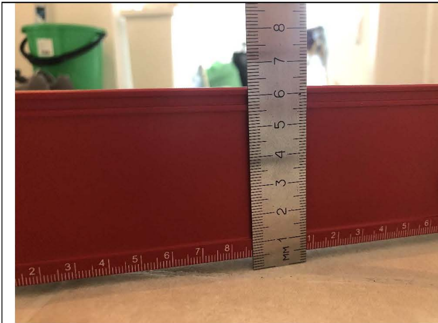
Фото №19. Измерение напольного покрытия коридора в квартире.
