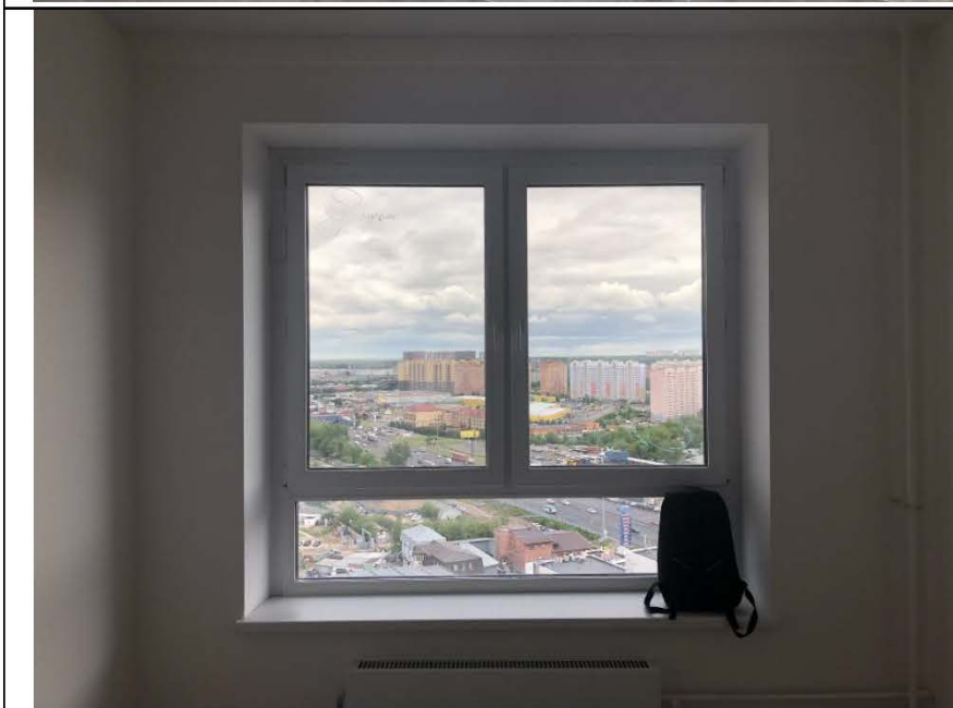
Фото №14. Общий вид оконного блока спальни в квартире.
